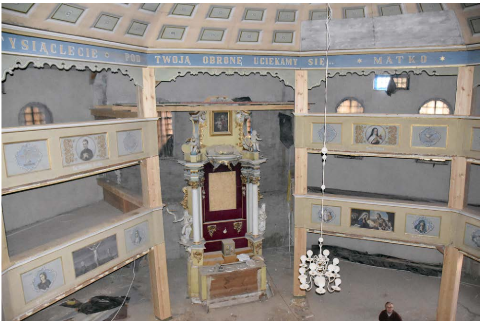
Fot. 86. Sułów, kościół pw. Najświętszej Maryi Panny Częstochowskiej, widok wnętrza w kierunku wschodnim.
