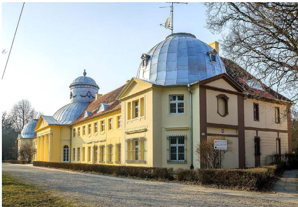
Fot. 29. Milicz, pałac, widok elewacji ogrodowej od południowego wschodu.
