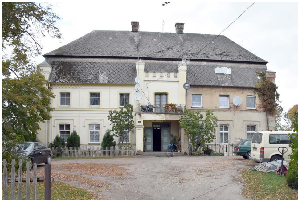
Fot. 142. Gołkowo, pałac, widok od południa.
