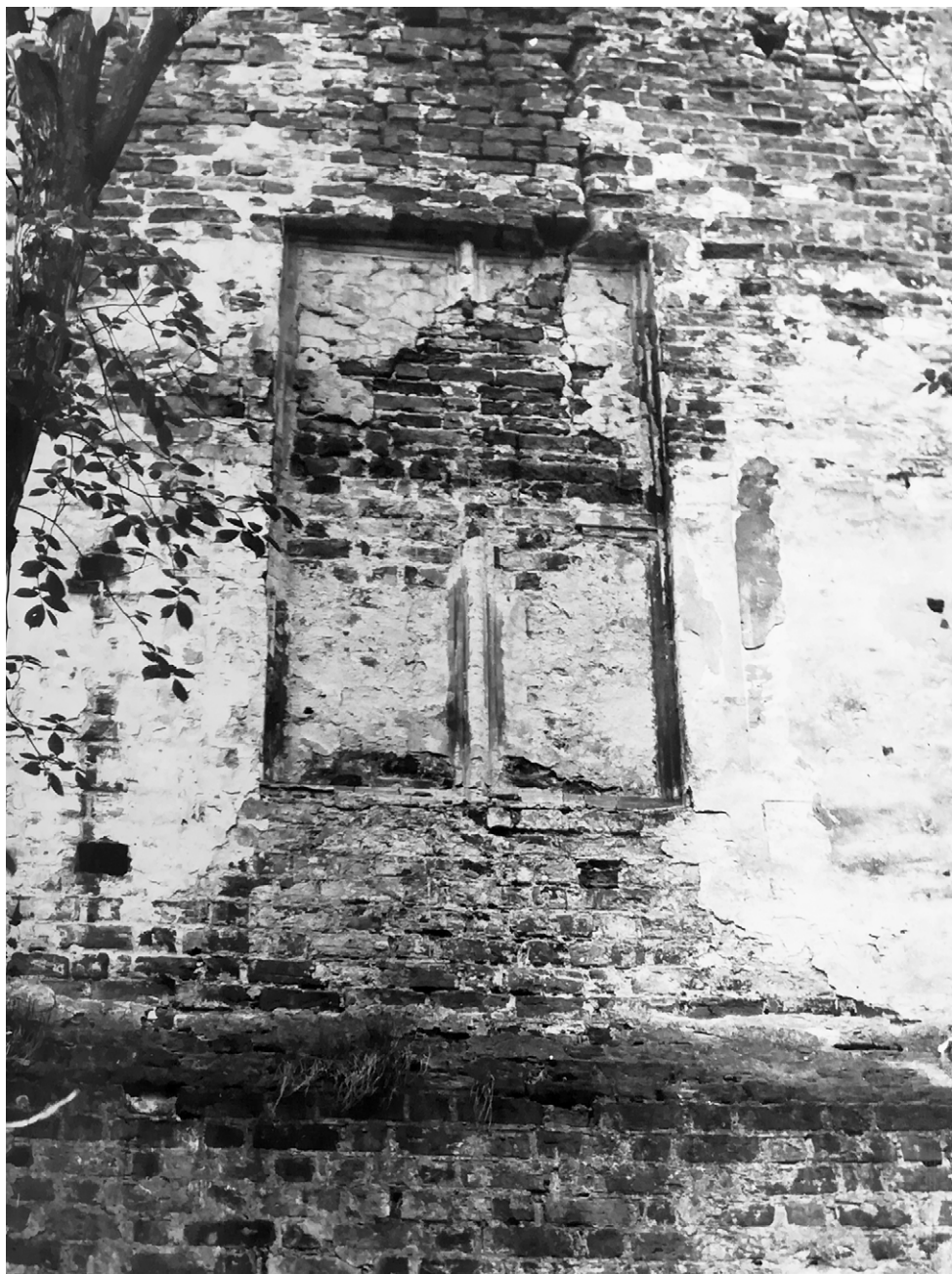
Il. 14. Milicz, zamek, pozostałości blendy w elewacji południowej domu zamkowego po regotycyzacji, reprodukcja w: Janina Eysymontt, Studium historyczno-architektoniczne ruin zamku w Miliczu (woj. wrocławskie) , Wrocław 1966, s. 19 (w archiwum WUOZ we Wrocławiu), fot. 11.
