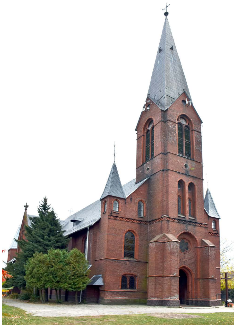
Fot. 119. Gądkowice, kościół św. Antoniego Padewskiego, widok od północnego zachodu.
