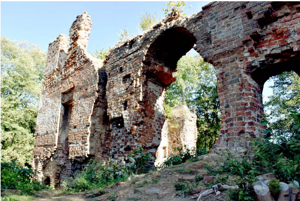
Fot. 10. Milicz, zamek, ściana zachodnia domu zamkowego.
