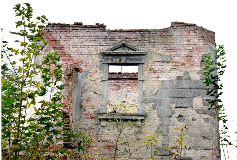
Fot. 132. Wziąchowo Małe, fragment zrujnowanego pałacu.
