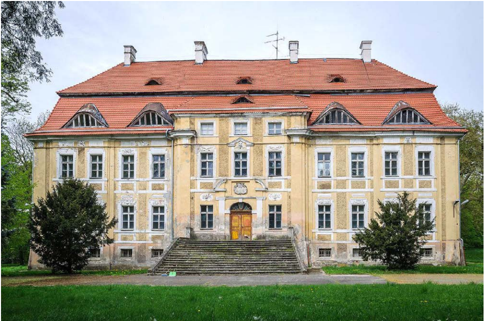
Fot. 24. Sułów, pałac, fasada, widok od wschodu.
