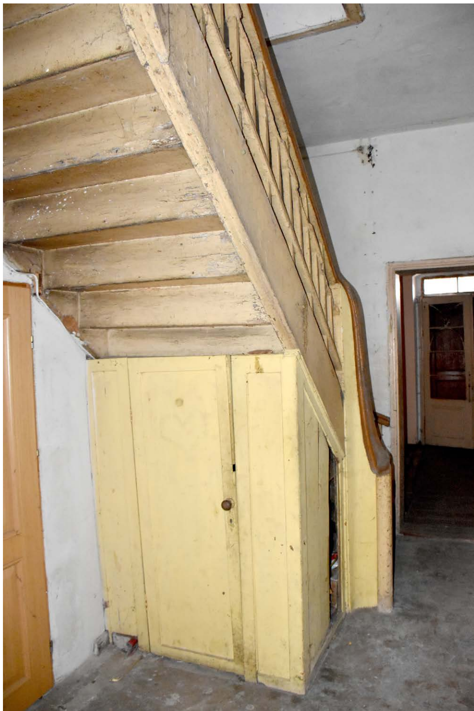
Fot. 141. Miłosławice, dwór, schody w sieni.
