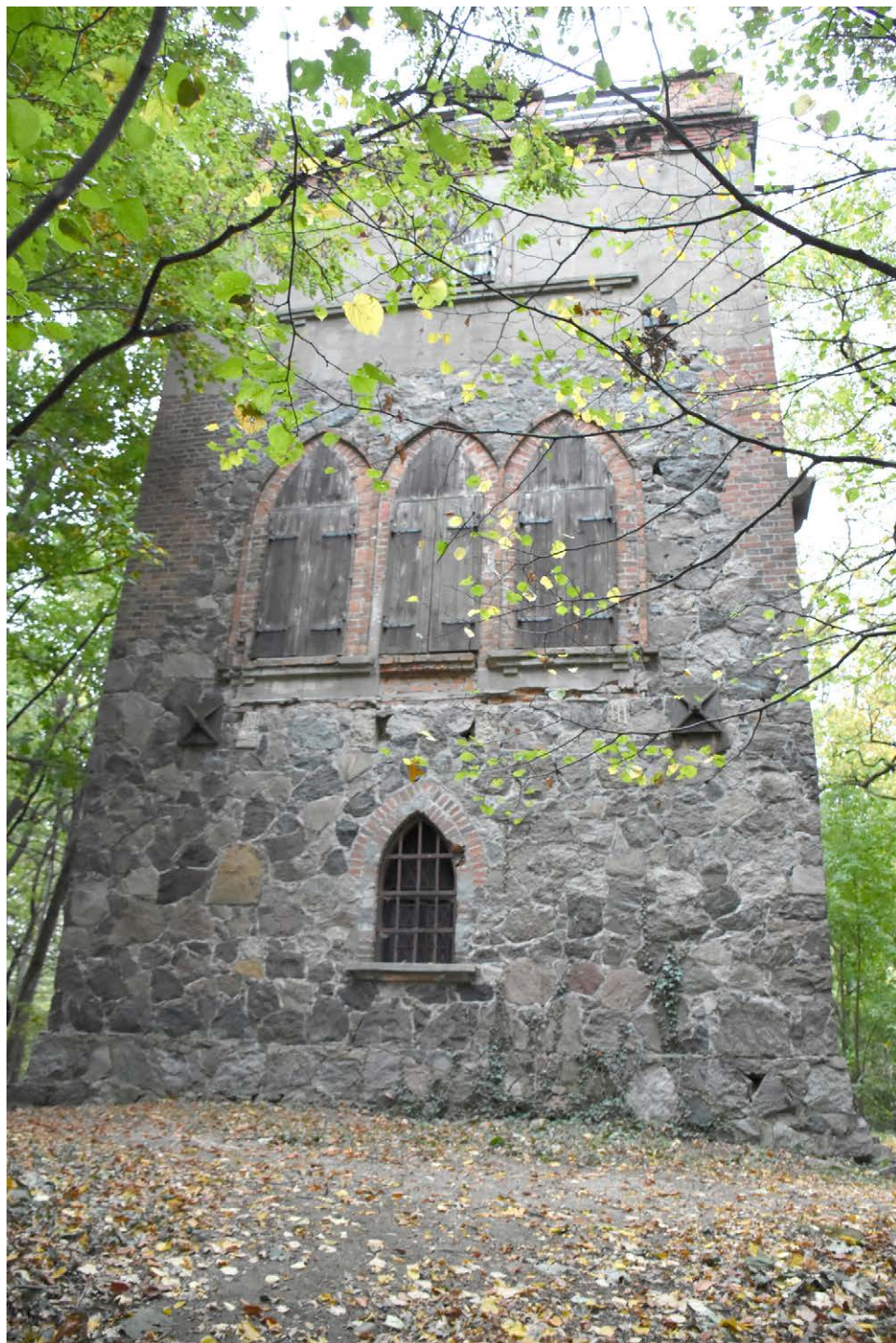
Fot. 147. Postolin, tzw. Wieża Odyniec, widok od zachodu.
