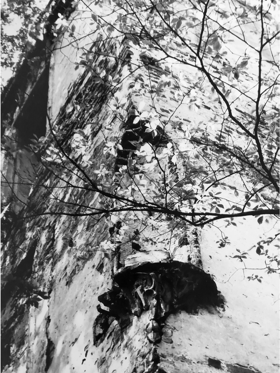
Il. 15. Milicz, zamek, nisza na rzeźbę w południowo-wschodnim narożniku domu zamkowego, reprodukcja w: Janina Eysymontt, Studium historyczno-architektoniczne ruin zamku w Miliczu (woj. wrocławskie) , Wrocław 1966, s. 19 (w archiwum WUOZ we Wrocławiu), fot. 8.
