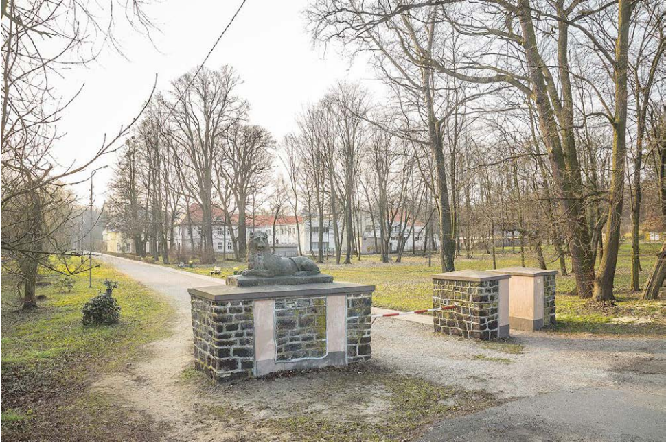
Fot. 58. Milicz, pozostałości łuku triumfalnego, widok od wschodu.
