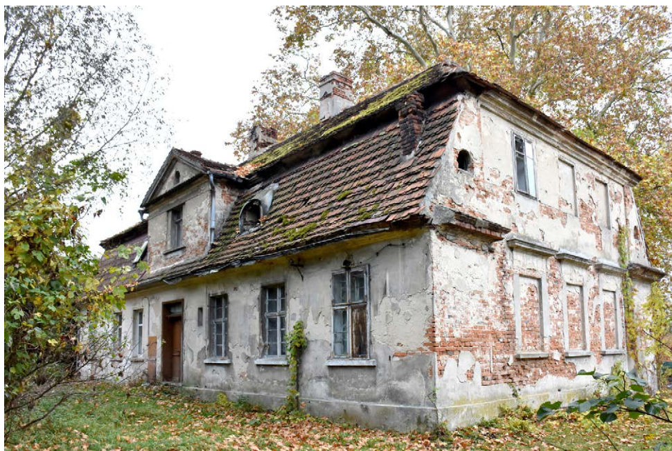
Fot. 140. Miłosławice, dwór, widok od północnego zachodu.
