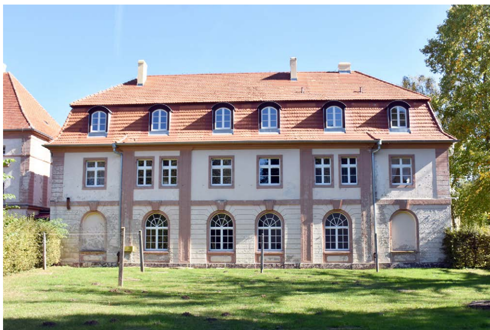
Fot. 53. Milicz, dawny dom zajezdny, elewacja zachodnia.
