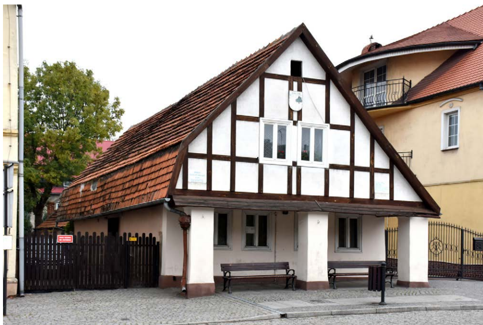
Fot. 28. Sulów, dom podcieniowy Rynek 11, widok od wschodu.
