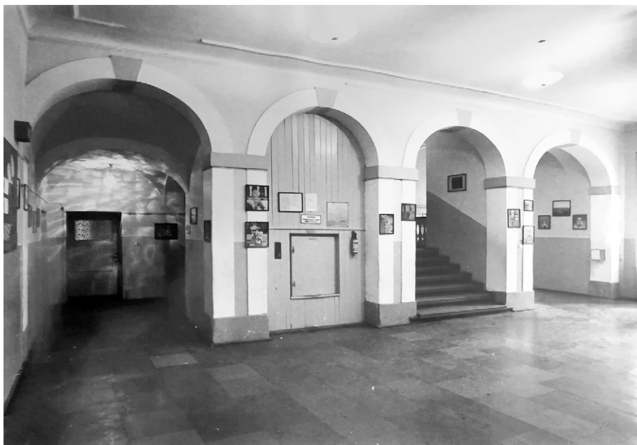
Il. 30. Sułów, pałac, arkady otwierające się na klatkę schodową i korytarzyki w przyziemiu, fotografia z: Hanna Wrabec, Jan Wrabec, Studium historyczno-architektoniczne pałacu w Sułowie , Wrocław 1987, fot. 56.
