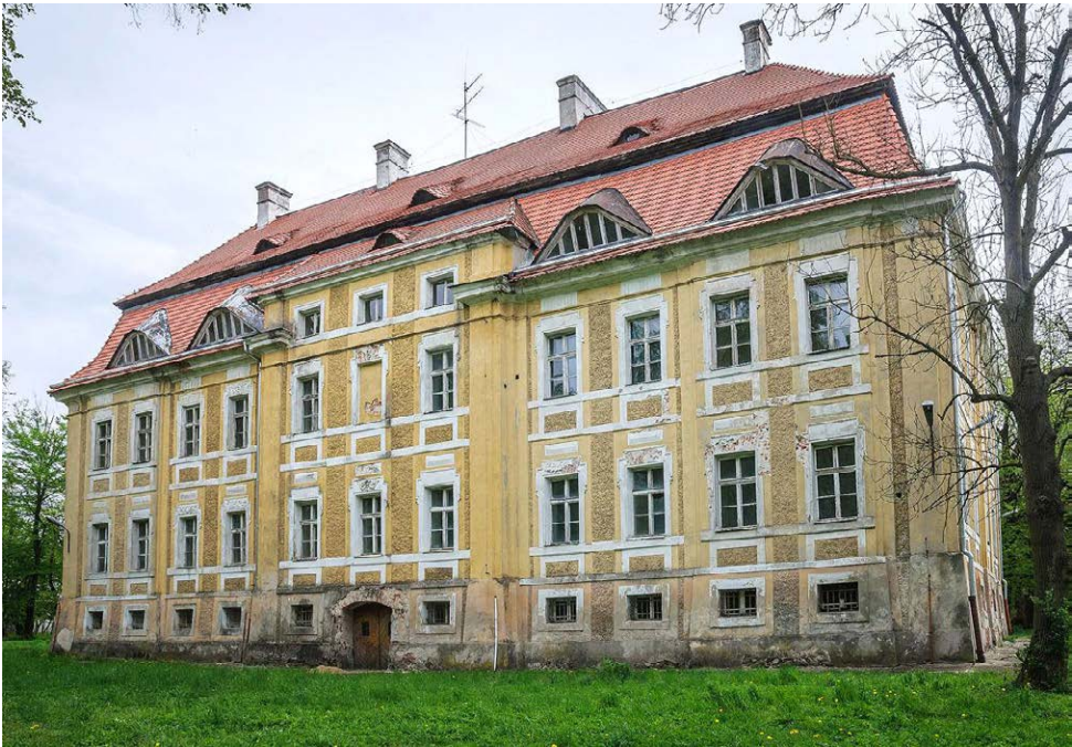
Fot. 26. Sulów, pałac, widok elewacji tylnej od zachodu.
