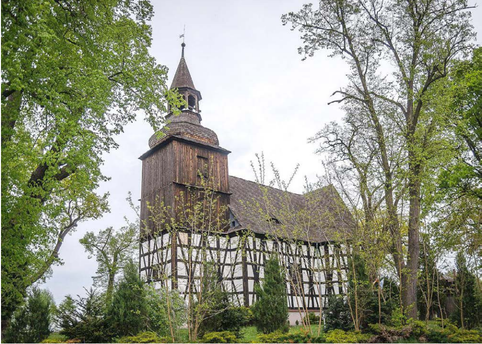
Fot. 73. Sulów, kościół pw. św. św. Piotra i Pawła, widok od południowego zachodu.
