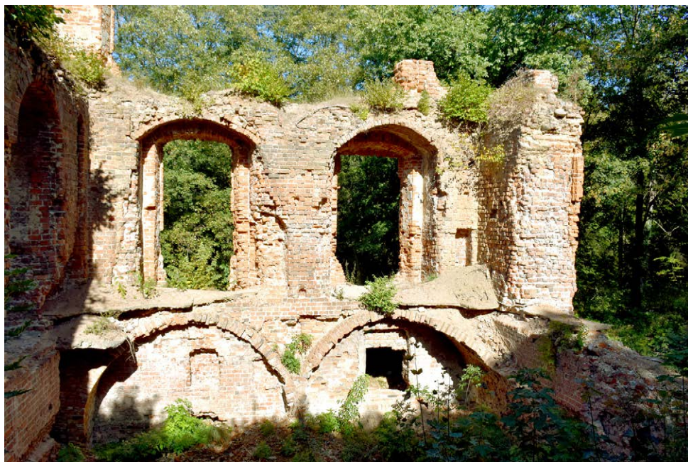
Fot. 7. Milicz, zamek, widok północnej ściany domu zamkowego od wewnątrz.
