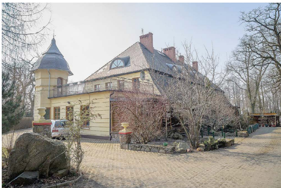
Fot. 138. Wziąchowo Wielkie, dwór, widok od północnego wschodu.
